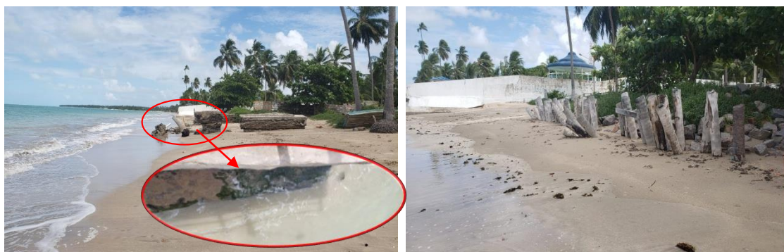
Figura 123, Escombros das obras de contenção.Figura 124, contenção por enrocamento.
