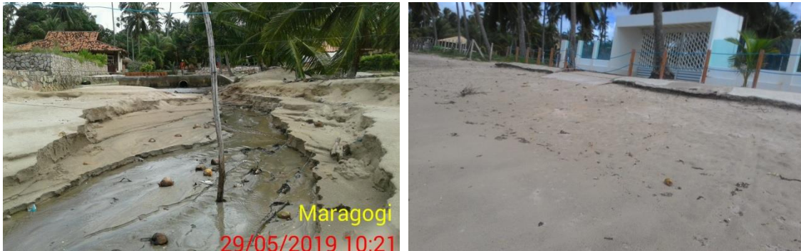
Figura 98, drenagem de águas pluviais. Figura 99, ocupação em área de uso comum.
