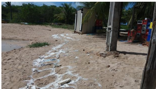
Figura 17, estrutura de banheiro precária.
