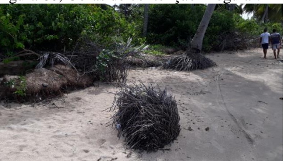
Figura 62, Orla em erosão.
