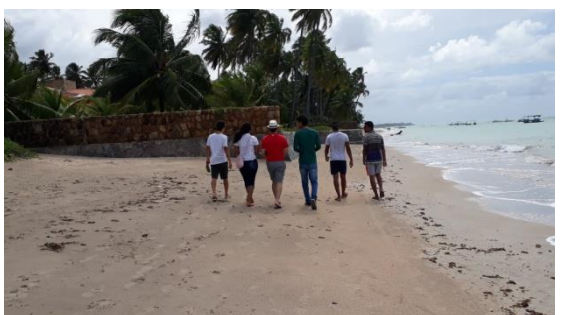
Figura 59, Orla em erosão.
