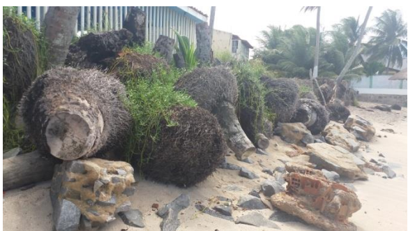
Figura 27, processo de erosão.
