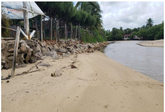
Figura 115, Obra de contenção rio.
