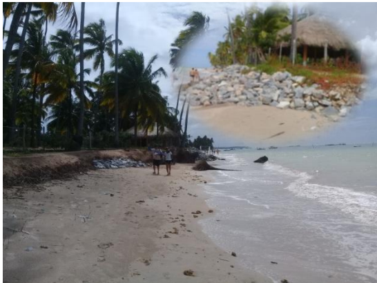
Figura 40, Obra de contenção na praia.
