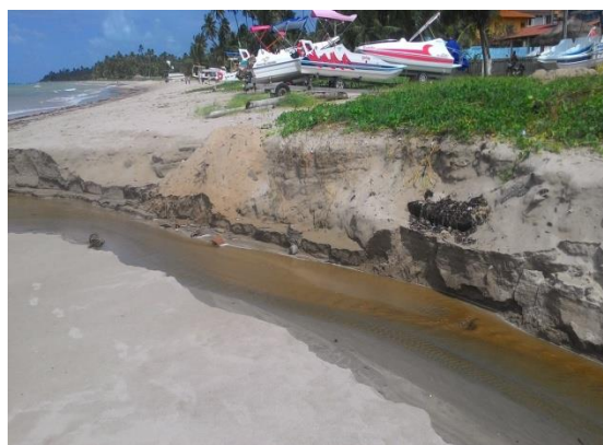
Figura 105, drenagem de água pluvial.
