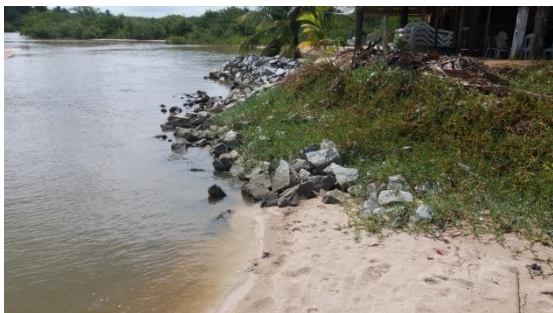
Figura 16, enrocamento de contenção.
