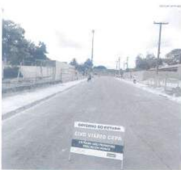
Obras aguardam desembargo por parte de Ithama, pendente para esta página, para dar andamento à obra
