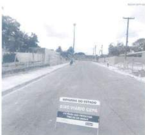
Trabalho aguarda retomada por parte de Ibama, prevista para esta quinta, para dar continuidade a obras
