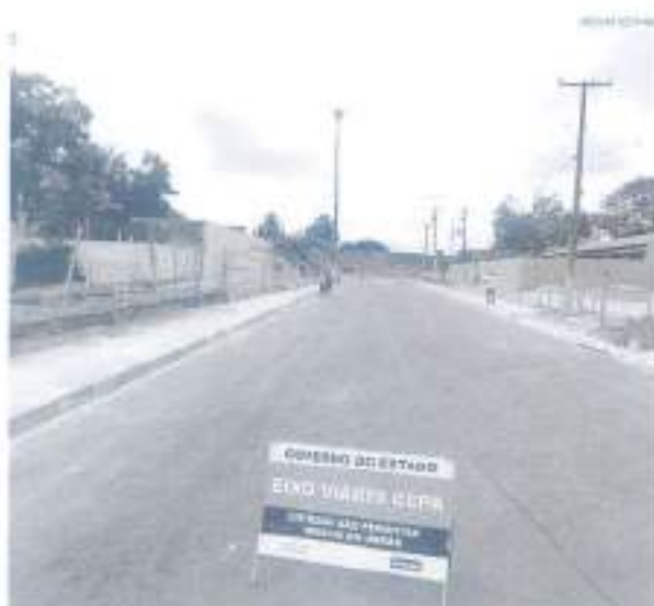
Obras aguardam desembargos por parte de Itama, porém já está feita a petição para dar continuidade a obra
